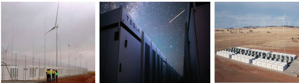
Рис. 2. Акумуляторна батарея Hornsdale Power Reserve, The Hornsdale windfarm (ветряная ферма Хорнсдейл)
